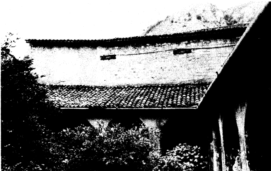
Fig. 8 - Muro perimetrale sud
